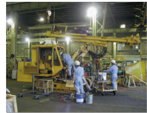
クローラドリルの修理
