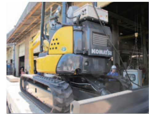
ミニショベルの電動化改造工事
