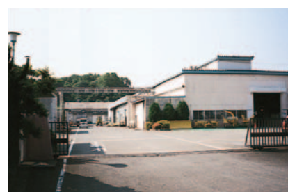
厚木工場:敷地39,200m 2
