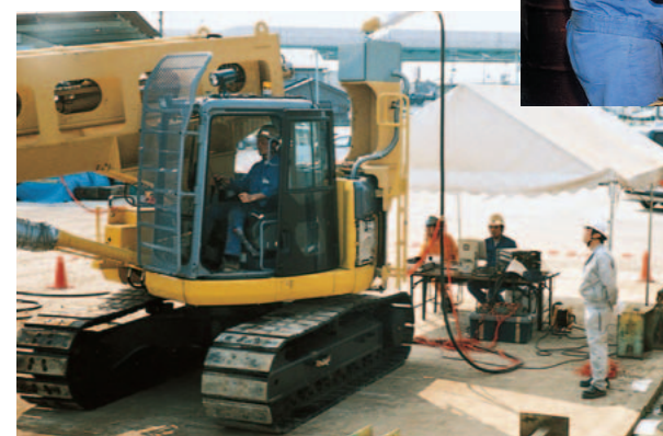
転炉解体機の応力テスト
