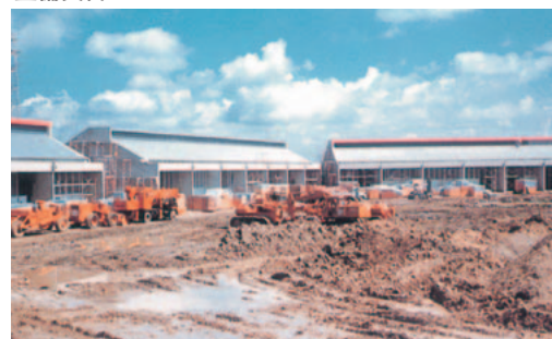
整備工場等の建設
